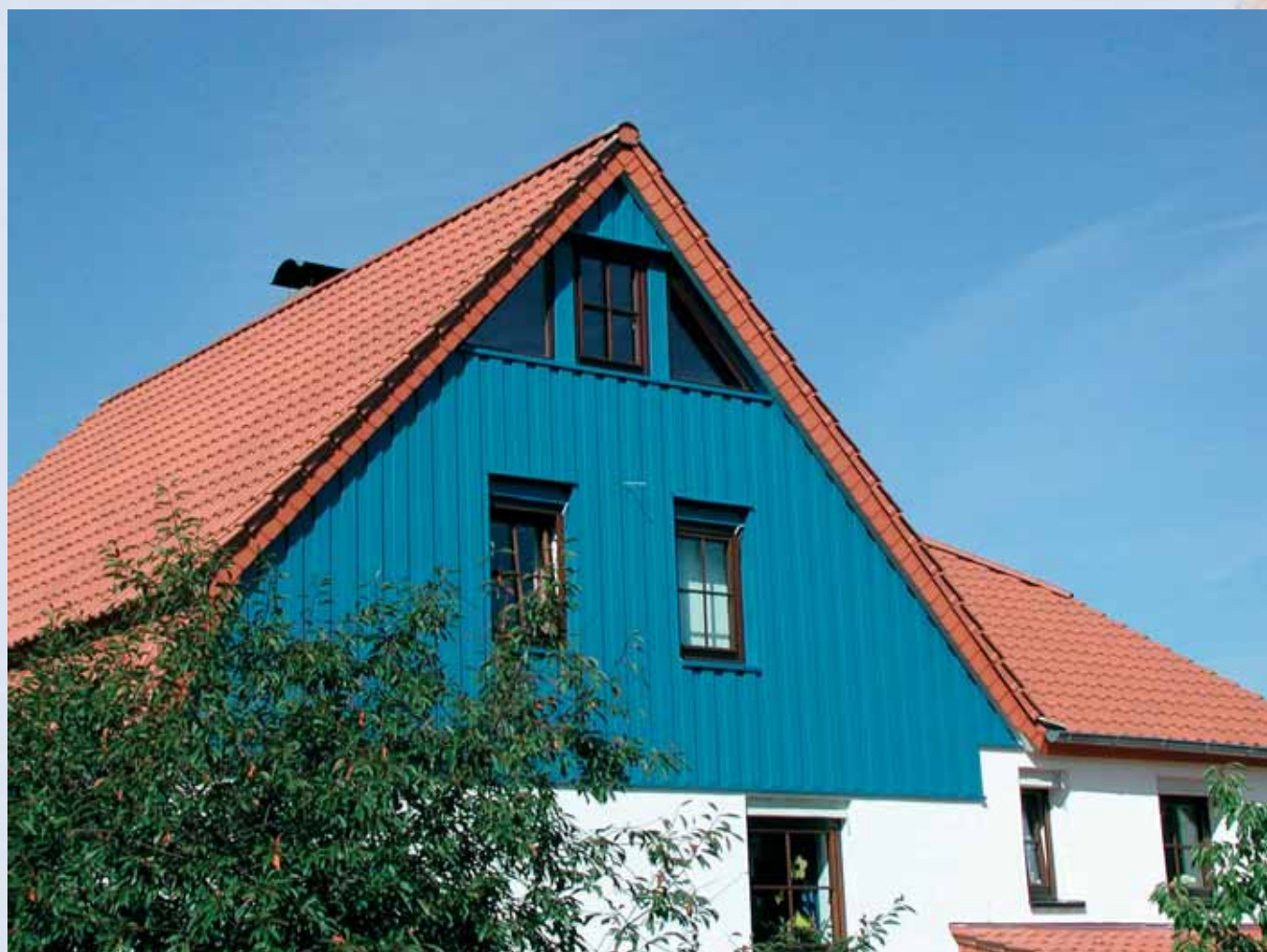
Lip-Klick Fassade azurblau, Fenstereinbindung mit Nischenausbildung für Rondo-Rollläden
