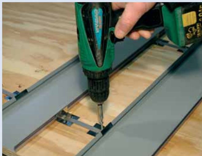
Nächstes Element einsetzen und Hafter montieren
