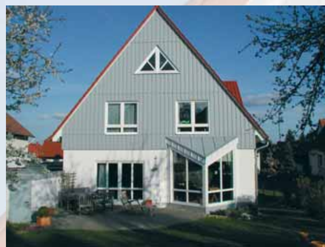
Giebelverkleidung zinngrau mit Stockwerks-Trennprofil, Fenstereinbindung incl. Dreiecksfenster
