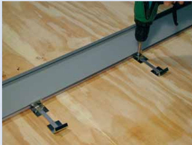
Bodenteile ausrichten und befestigen
