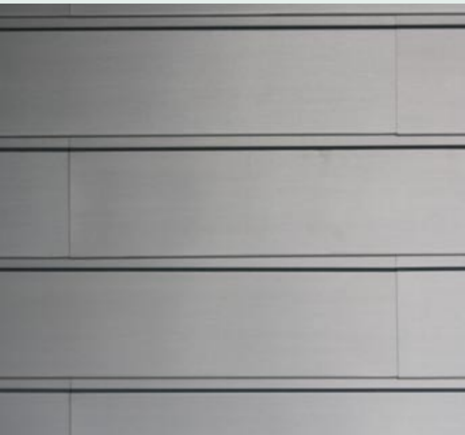
Fassadengestaltung horizontal in gleichmäßigem Verband
