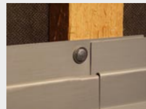
Befestigung mit Bohrschrauben außerhalb der Naht
