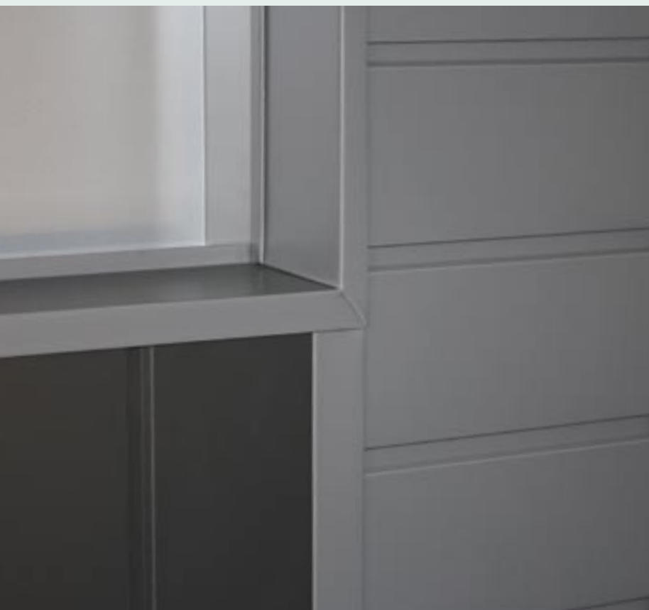
Übergang horizontal / vertikal einschließlich Fensterbankanschluss
