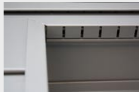
Übergang Laibung / Fenstersturz
