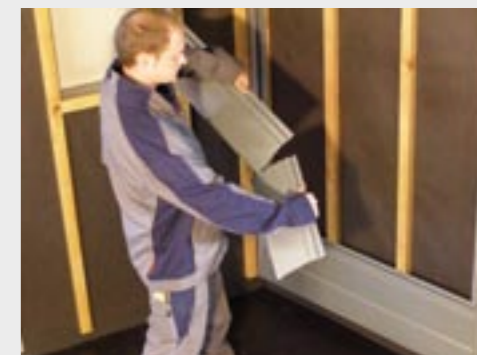
Systemmontage auf Holzunterkonstruktion
